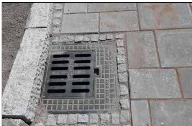
Jupalcon ASY - kansisto asennettuna reunakiven viereen.
