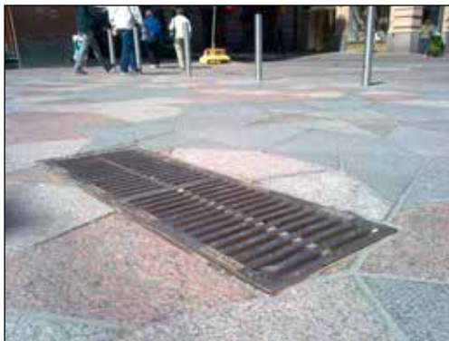
Jupalcon suorakaidekansisto asennettuna Helsingin Keskuskadulle.
