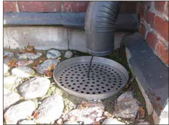
Sadevesikaivo. Kaivoon asennettu hiekankeräysallas \varnothing 445 mm
