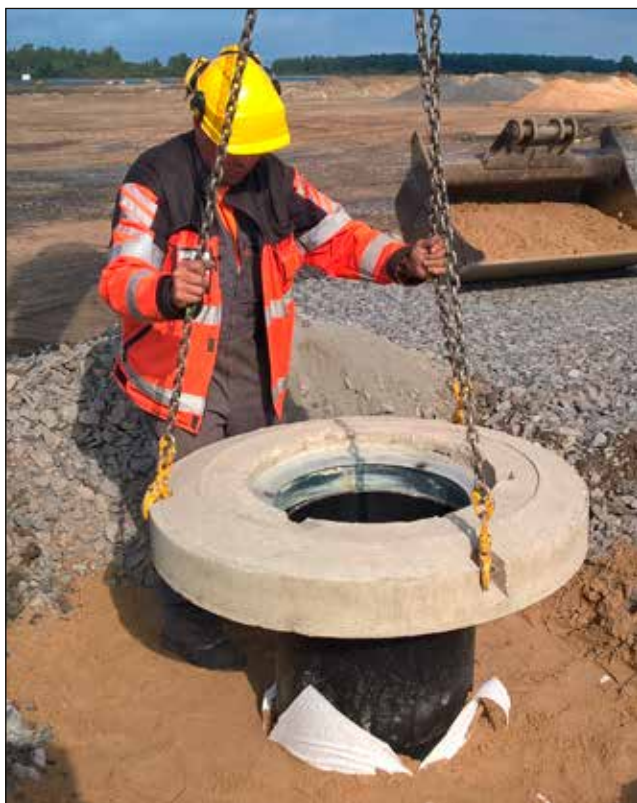
Betonisen perustuksen asennus muoviputkelle Ø 500 mm.
